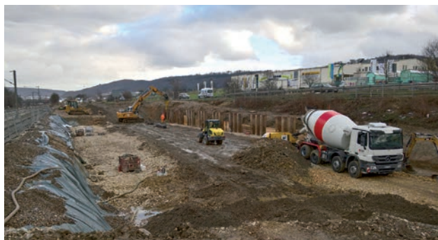
Stand der Bauarbeiten im Januar 2018
